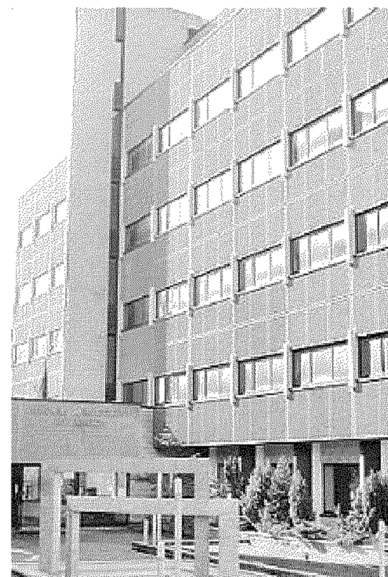
La sede del Tar Abruzzo
