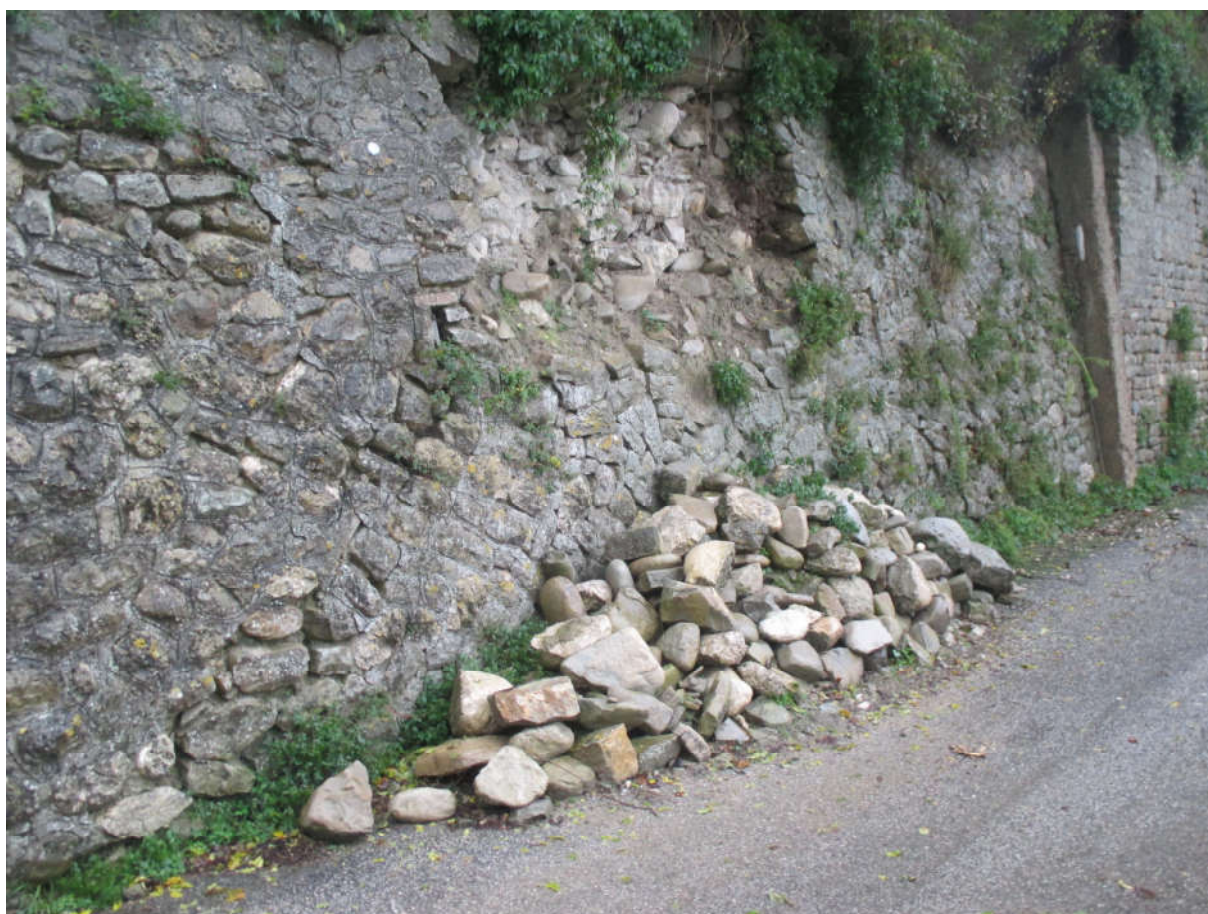
Particolare muro di contenimento in pietrame
